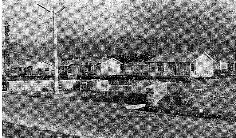
RESİM 34 — Osmaniye istasyonu merkez tesislerinden bir görünüş
